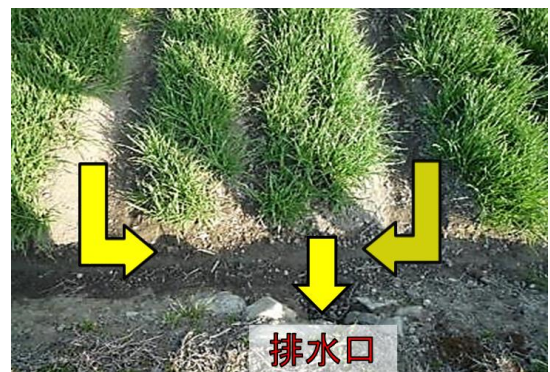
溝を排水口につなぎ、地表水を排水
